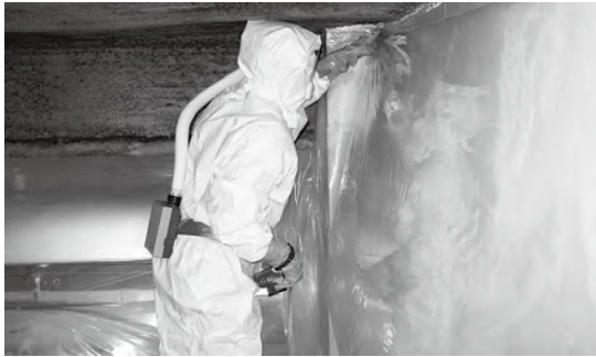
アスベスト除去等作業現場の立入調査
