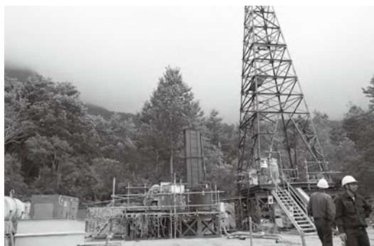
ヒートホール掘削調査
