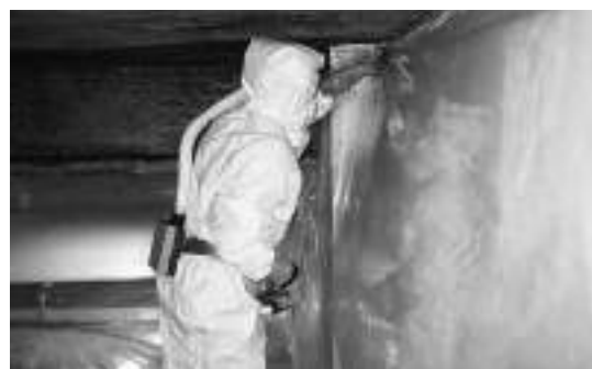
アスベスト除去等作業現場の立入調査
