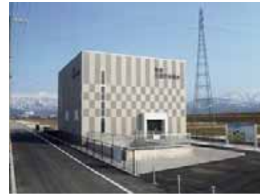
小摺戸発電所（入善町）
