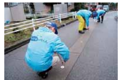
「地下水の守り人」の活動 （消雪用散水ノズルの点検）
