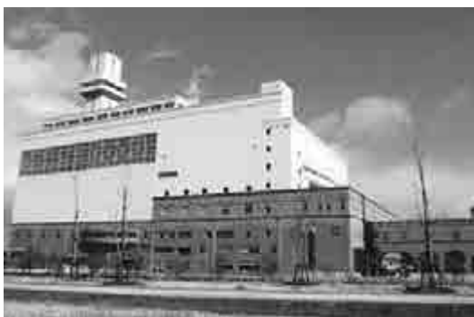
発電付焼却炉
