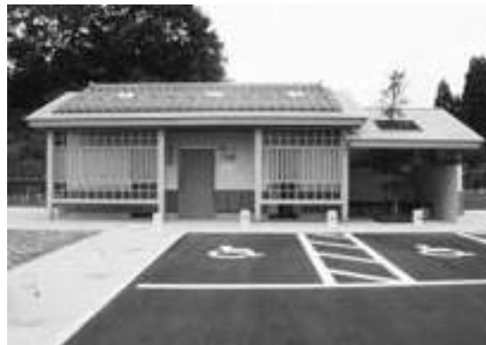
グッドトイレコンテスト「さわやか賞」受賞施設 （太閤山公園墓苑トイレ）
