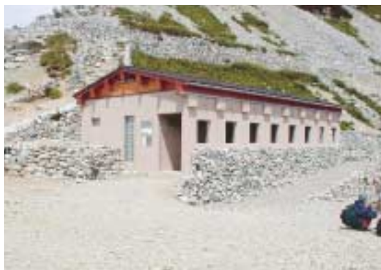
立山ノ越公衆トイレ
