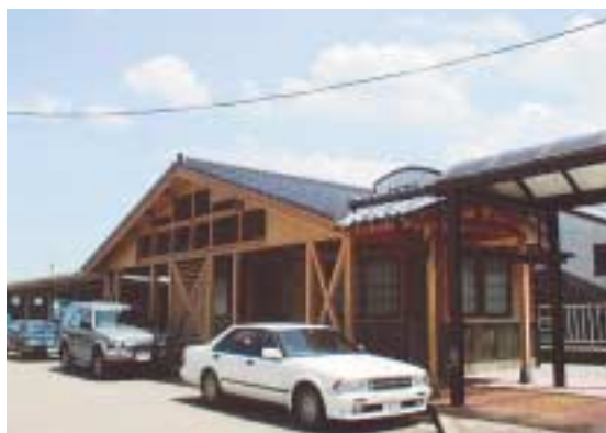
福光駅前公衆トイレ
