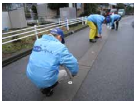
散水ノズルの点検
