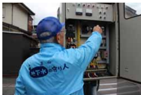
消雪設備の操作盤の調整
