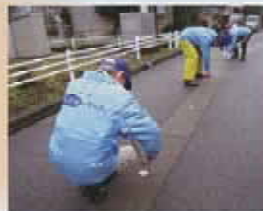
散水ノズルの点検
