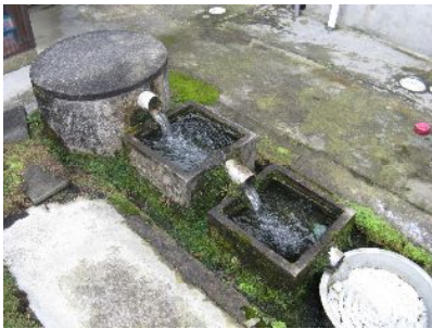
砂落としのための水槽を備えた昔ながらの自噴井戸 【富山市水橋地区】
