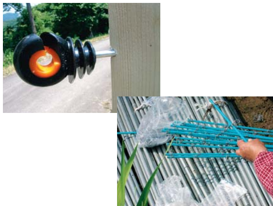
②碍子、クリップを取り付ける
