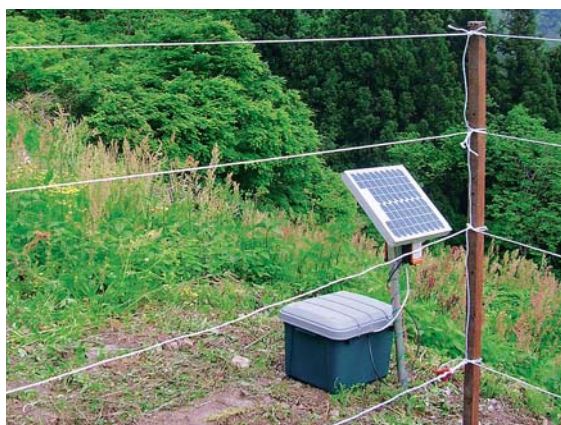
⑤電源の設置
