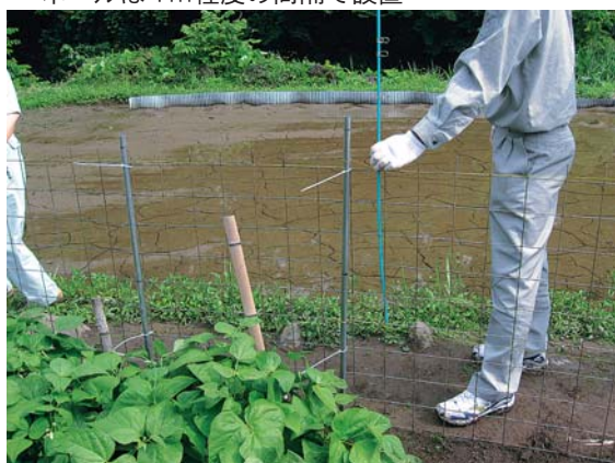
⑥ワイヤーメッシュ上部にポールを設置する ポールは4m程度の間隔で設置
