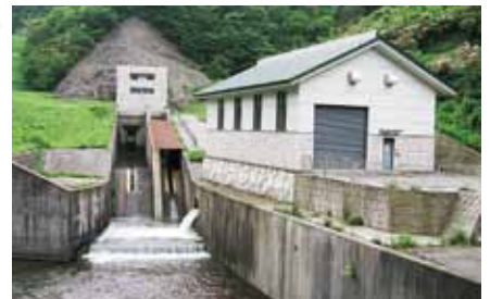
臼中発電所(農業用水を利用した小水力発電)
