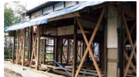
住宅の耐震改修工事
