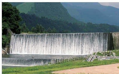
本宮砂防堰堤
