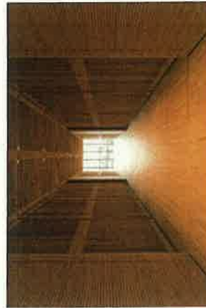
富山県美術館における県産材を使った内装の木質化
