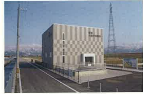
小摺戸発電所
