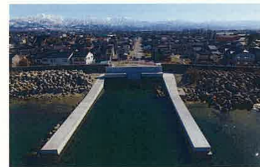
河川(放水路)の整備(沖田川放水路)
