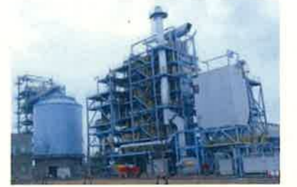
未利用間伐材を活用した 木質バイオマス発電施設 射水市、出力5,750kW (株)グリーンエネルギー北陸
