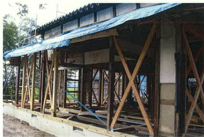
住宅の耐震改修工事
