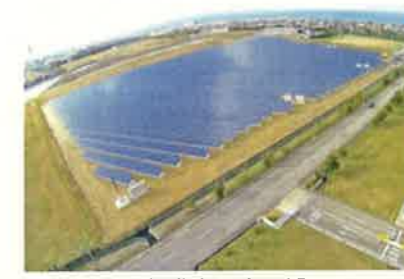
富山新港太陽光発電所 射水市、出力4,500kW (県企業局)
