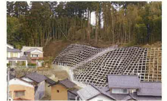
急傾斜地崩壊防止施設の整備(氷見市朝日丘地区)
