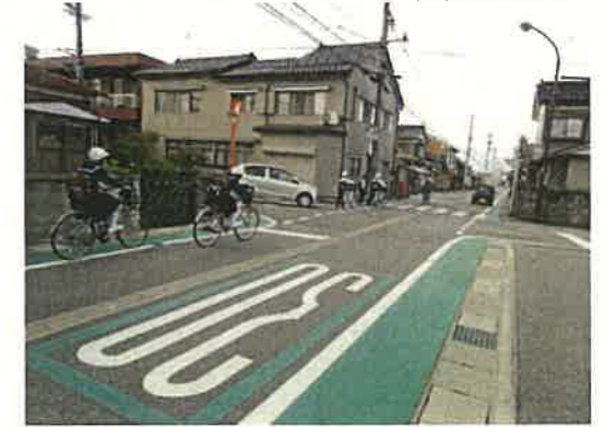
路側帯のカラー舗装化等による 安全対策(立山町前沢地内)
