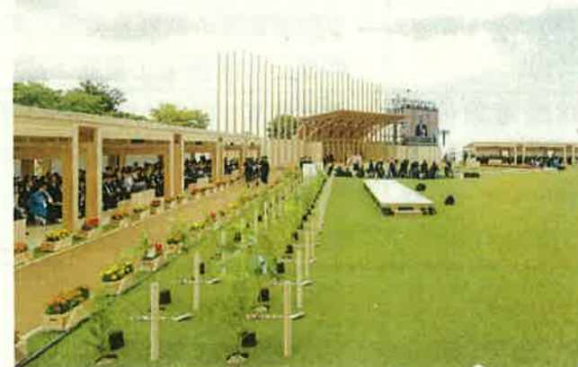
全国植樹祭では初めてとなる、柱や梁などの構造部材に県産材を使った木製テント
