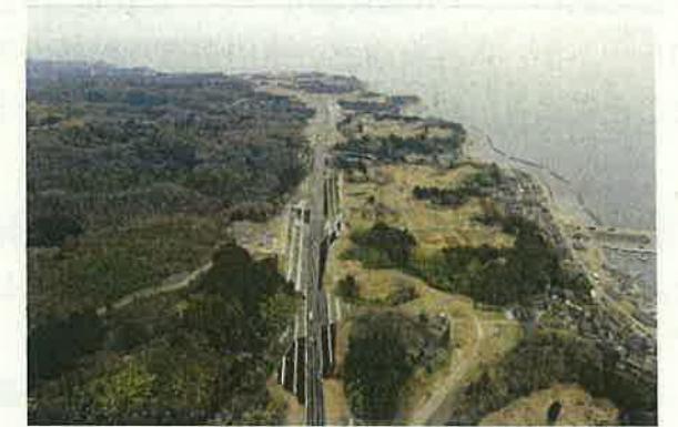
能越自動車道(七尾氷見道路) 提供:国土交通省北陸地方整備局
