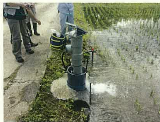
▲ICTを活用した自動給水栓
