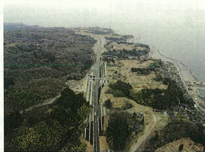
広域的な交流を促進する能越自動車道(七尾氷見道路) (出典:富山河川国道事務所)
