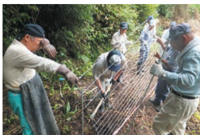
鳥獣被害防止の侵入防止柵
