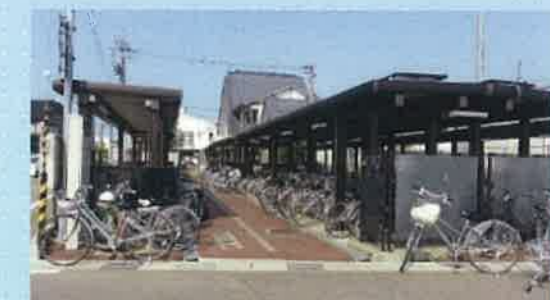
あいの風とやま鉄道首狩岡駅周辺駐輪場整備(高岡市) (平成25年度都市再生整備計画事業)
