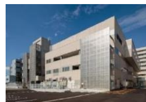
県立中央病院 先端医療棟
