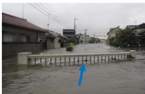
H24出水状況 (地久子川)
