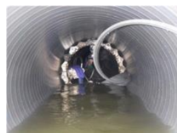
下水道施設の機能維持 (管更生工法)
