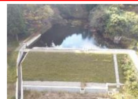
整備済みのため池
