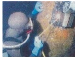
港湾岸壁の防食機能維持
