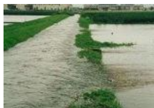
溢水被害防止対策前
