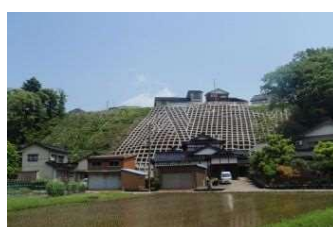
急傾斜地崩壊対策事業 (高岡市・城光寺地区)
