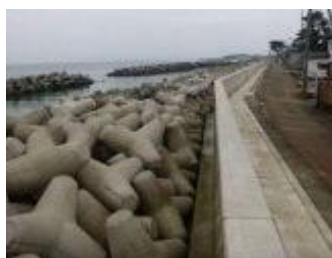
護岸改良・ブロック嵩上げ
