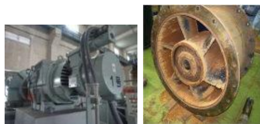
排水ポンプの補修
