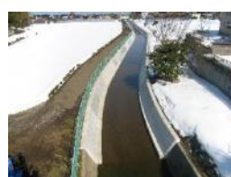
長寿命化対策後
