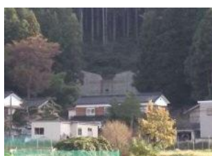
砂防堰堤の整備 (魚津市長引野東谷)
