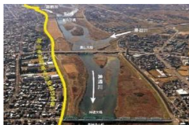
富山市街地重点防御築堤事業（富山市）
