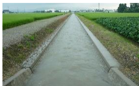
国営附帯県営農地防災 (庄川左岸地区) 改修後の狐島用水路(砺波)
