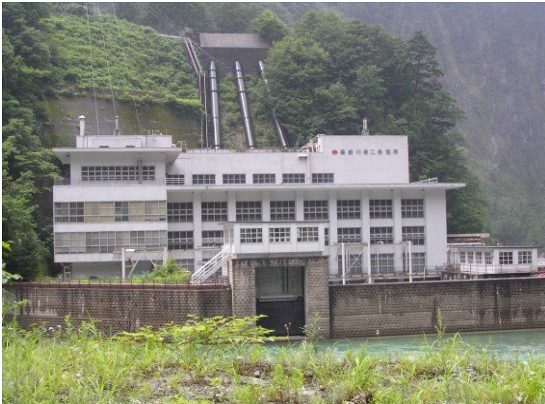
黒部川電源開発施設（黒部川第二発電所）
