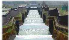
落差を有する農業用水路
