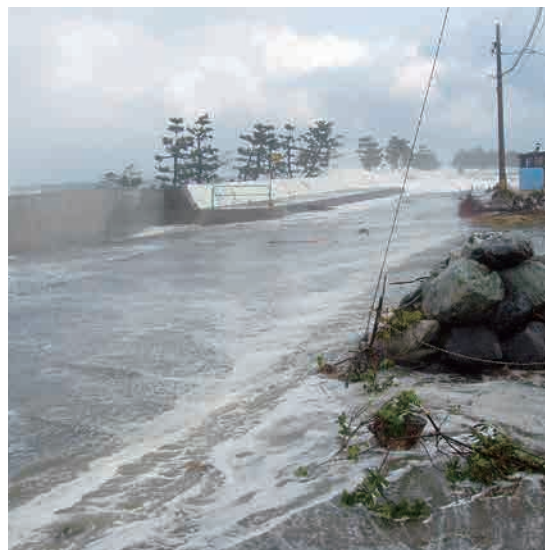
平成20年2月24日の高波災害(入善町芦崎)
