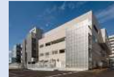
中央病院先端医療棟
