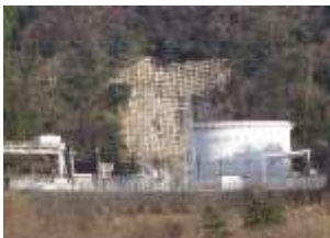
重要インフラ(発電所) の保全(砺波)
