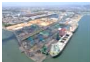
新湊地区(中央岸壁)
