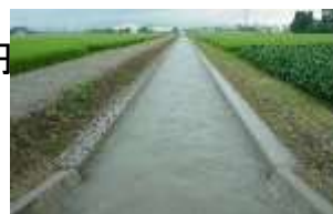
国営附帯県営農地防災(庄川左岸地区) 改修後の狐島用水路(砺波)
