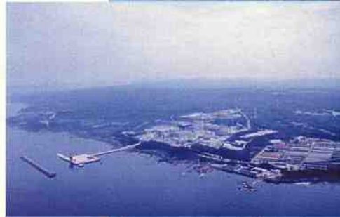
志賀原子力発電所
