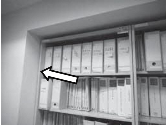
写真3 国際健康プラザ 壁面埋込型キャビネット 写真4 水墨美術館 TVモニターをストラップで固定
