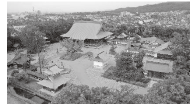
勝興寺修理後全景
